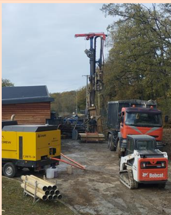
Un forage en cours de réalisation.
